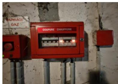
Boîtier de coupure extérieure
