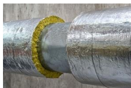
Calorifugeage laine minérale
