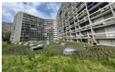
Végétalisation (chantier Reanova)
