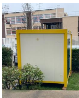
Exemple de WC
