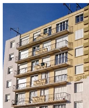
Isolation sous enduit mince, en cours et terminée
