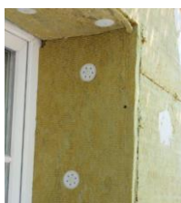
Isolation des tableaux voissures
