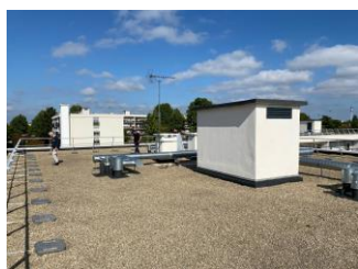
Toiture gravillonnée terminée
